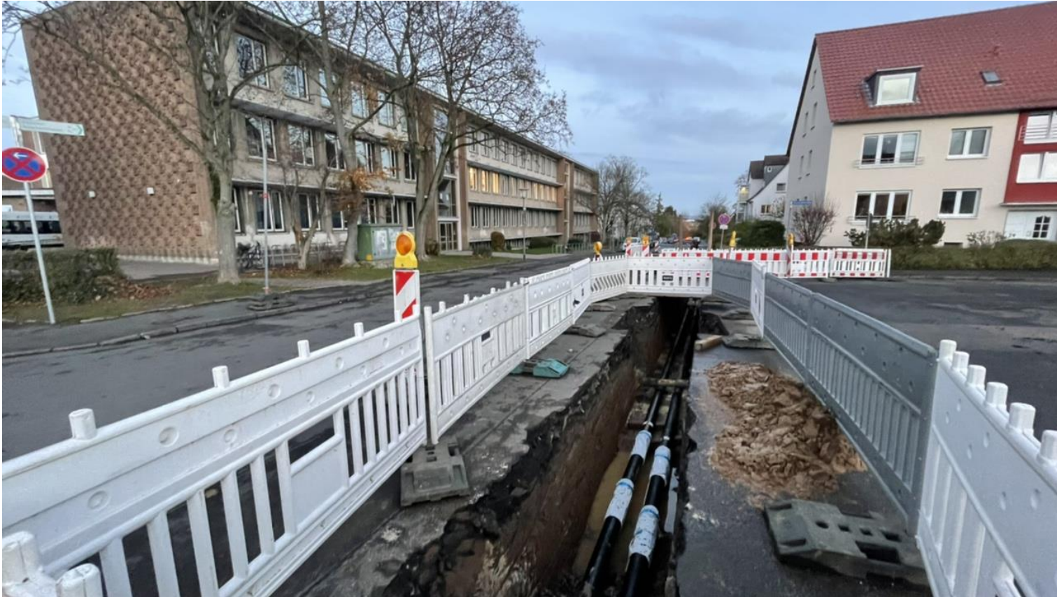
Fernwärme-Ausbau im Umfeld des Wilhelmsgymnasiums
