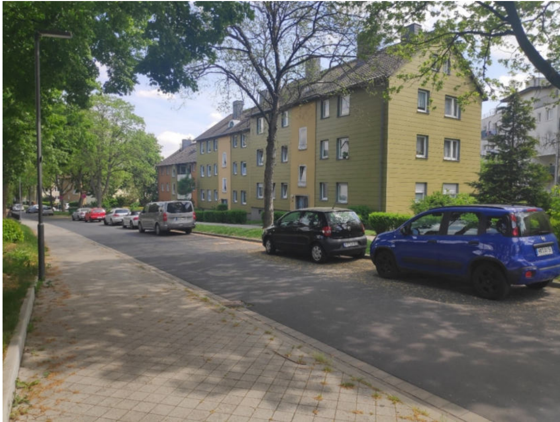
Abb. 3: Blick auf die Südseite der Ziegenhainer Straße
