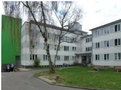
Ehem. Schwestern-Wohnheim, Frankfurter Straße 167A
