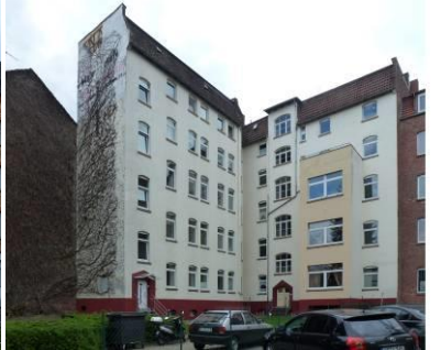
Hinterhaus Frankfurter Straße 157 (links)
