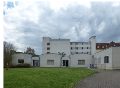
eingeschossiger OP-Trakt von Norden
