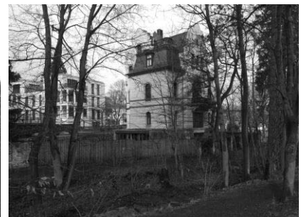
Neubau und Villa rückwärtig
