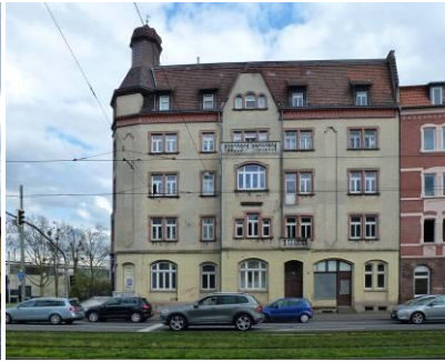
Eckgebäude Frankfurter Straße 153 von Westen
