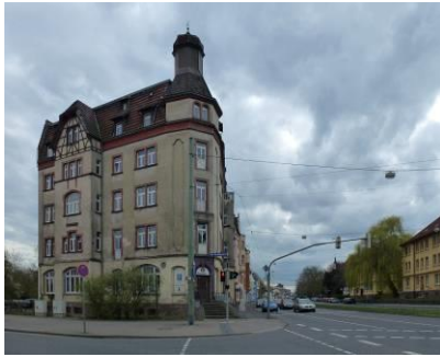
Eckgebäude Frankfurter Straße 153 von Norden
