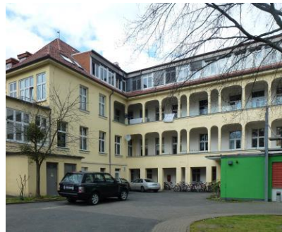
Gebäude Frankfurter Straße 167 von Süden
