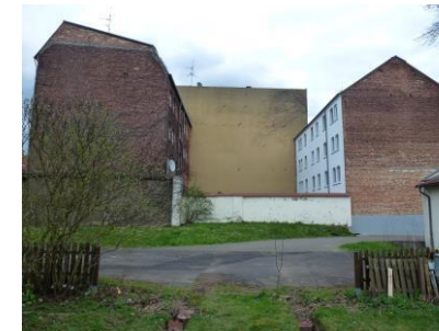
Blick über die Baulücke Richtung Norden auf Vorder- und Hinterhaus Frankfurter Straße 161
