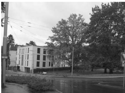
Blick auf die Gebäude und den Grünzug von Westen
