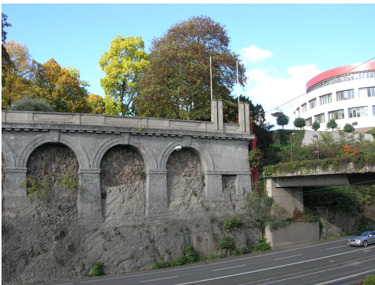
Substruktionsbögen und Fußgängerbrücke, Frankfurter Straße, rechts Elisabeth-Krankenhaus
