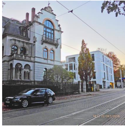
Villa Kurhausstraße 30 mit Neubau
