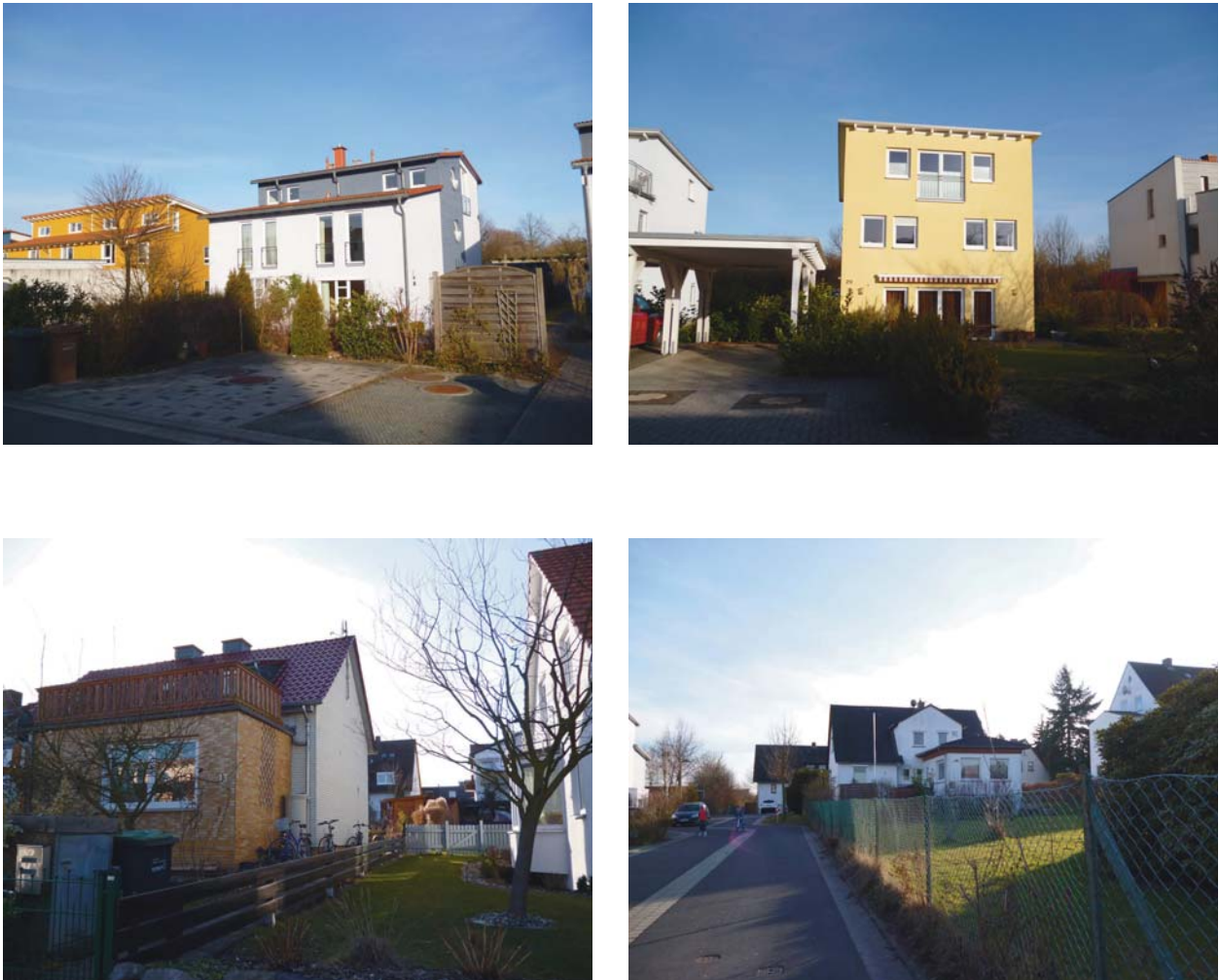
Abbildung 17 - 20: vorhandene Gebäudetypologien im Plangebiet und im Umfeld
