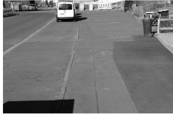
Abbildung 2-31: Großflächige Versiegelungen Waldecker Straße/Am Osterberg
