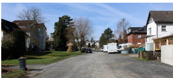
Abbildung 2-17: Blick von der Waldecker Straße auf den Übergang zu Am Ziegenberg ohne Endausbau
