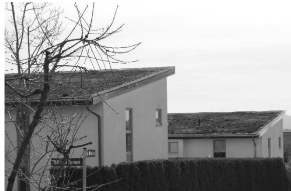
Abbildung 2-37: Dachbegrünung im Neubaugebiet
