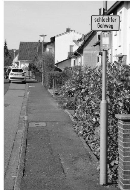
Abbildung 2-22: Schlechter Gehweg an Lambertweg
