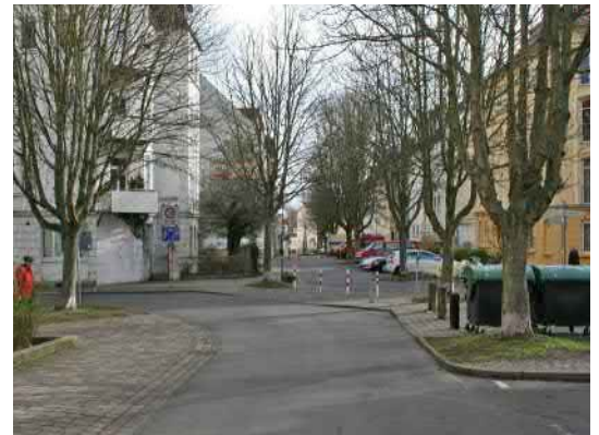
Fehlende Aufenthaltsqualitäten im Kreuzungsbereich Hentze-/Friedenstraße
