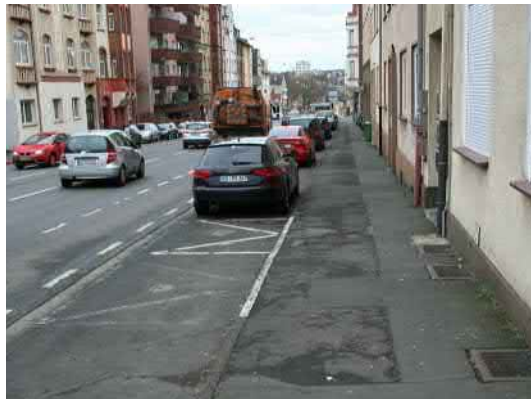
Mangelhafte Gehwege, fehlende Aufenthaltsqualität und Begrünung in der Kohlenstraße
