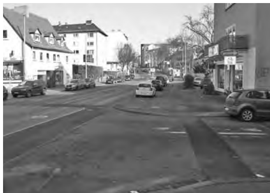
Das gleiche Bild ergibt sich an vielen Stellen in der Schönfelder Str.
