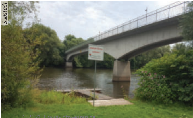
Schwimmbadbrücke über Fuldapromenade am Auebad
