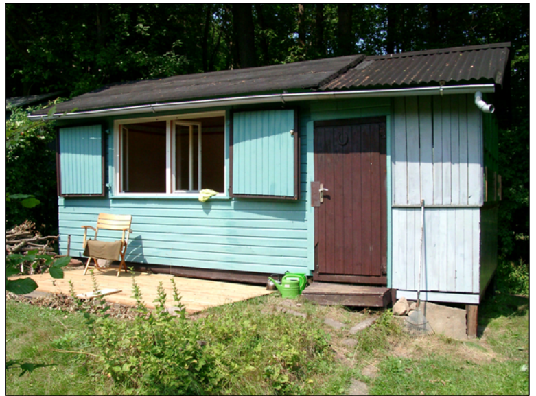
Laube, Dachdeckung rechts mit Bitumenwellplatten
