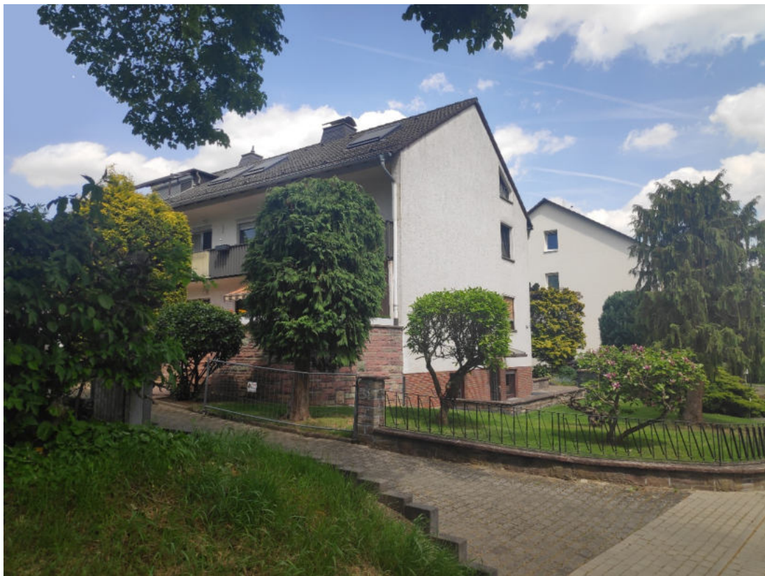
Abb. 4: Blick auf die Ziegenhainer Straße 26
