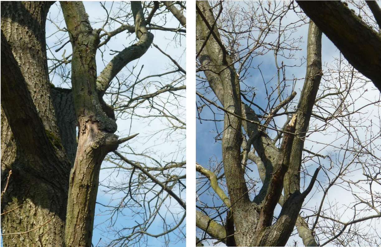
Abbildung 3: Abgestorbene/ abgebrochene Äste mit potentiellen Rindenquartieren für baumbewohnende Fledermausarten.
