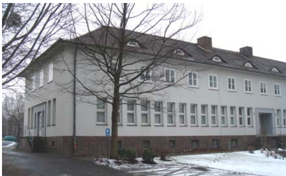
Gebäude der ehemaligen Landesfeuerweherschule Ansicht Ortelsburger Strasse
