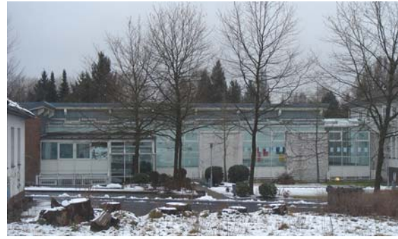
Erweiterungsbau aus den 80er Jahren des 20. Jhrdts.
