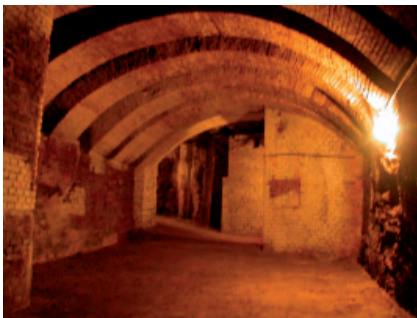
Foto eines Gewölbekellers der Stollenanlage
