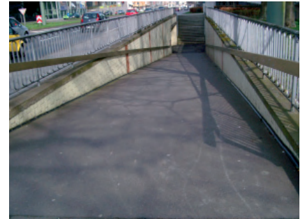
Fußgängerrampe vor dem Bellevue
