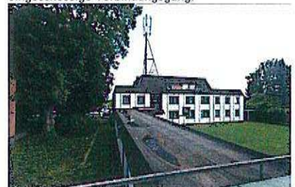
Blick über den eingeschossigen Verbindungsgang
