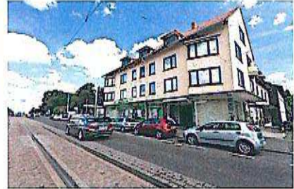
Wohn- und Geschäftshaus an der Frankfurter Straße
