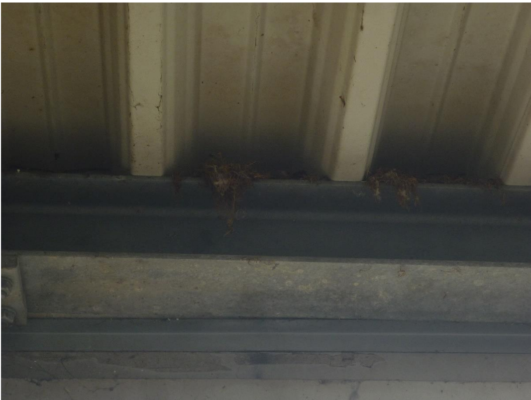
Abbildung 17: Vorjahresnest und begonnene Nester im Nebengebäude auf einem Deckenträger.
