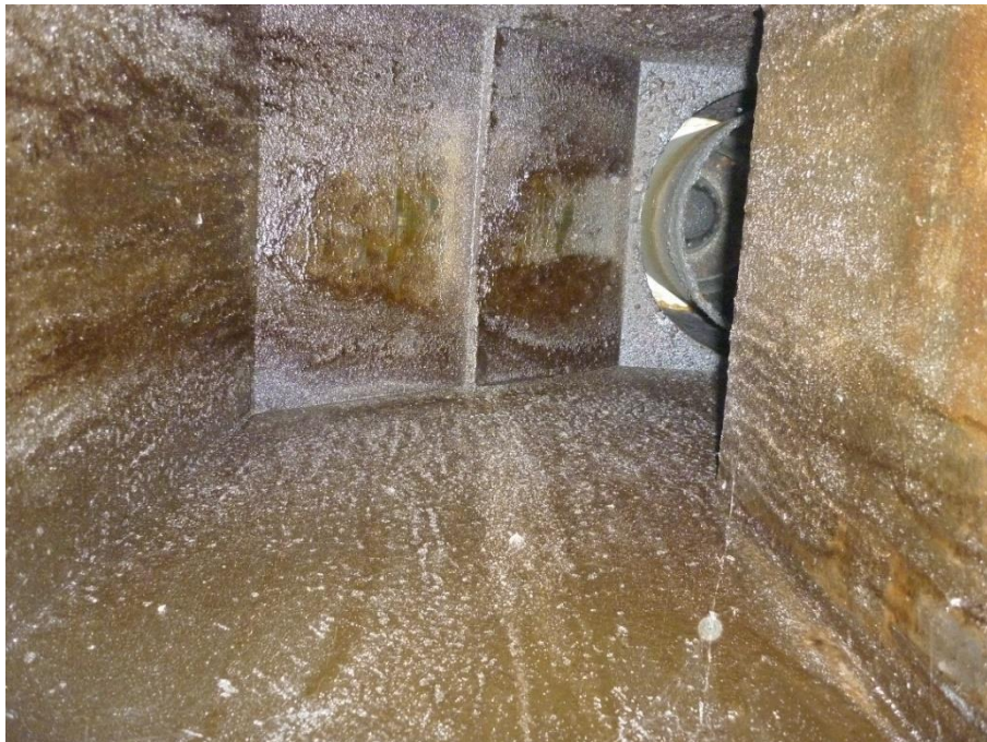
Abbildung 9: Blick in einen Belüftungsschacht von Innen.
