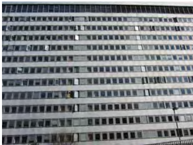
Gebäude der Arbeitsagentur, Grüner Weg
