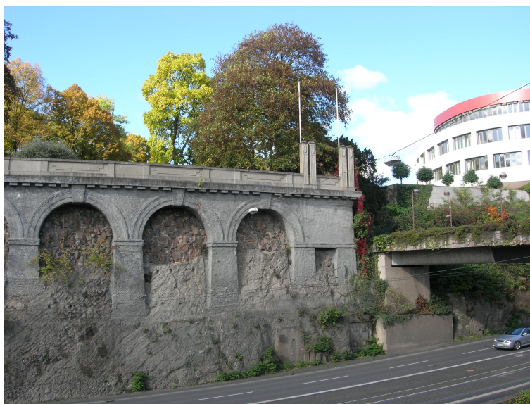
Substruktionsbögen und Fußgängerbrücke, Frankfurter Straße, rechts Elisabeth-Krankenhaus
