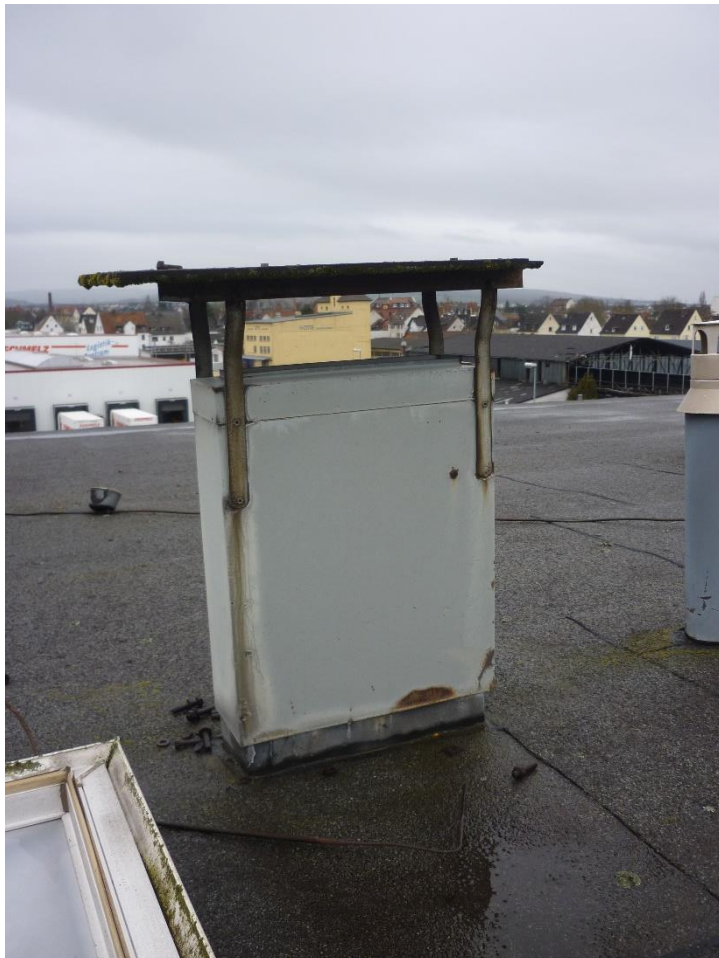
Abbildung 8: Lüftungsschacht auf dem Flachdach des Hotels.
