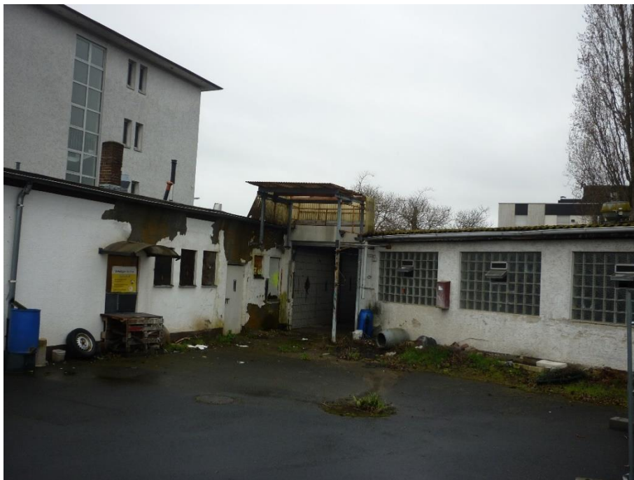
Abbildung 11: Blick auf den Zugang zu den Nebengebäuden.
