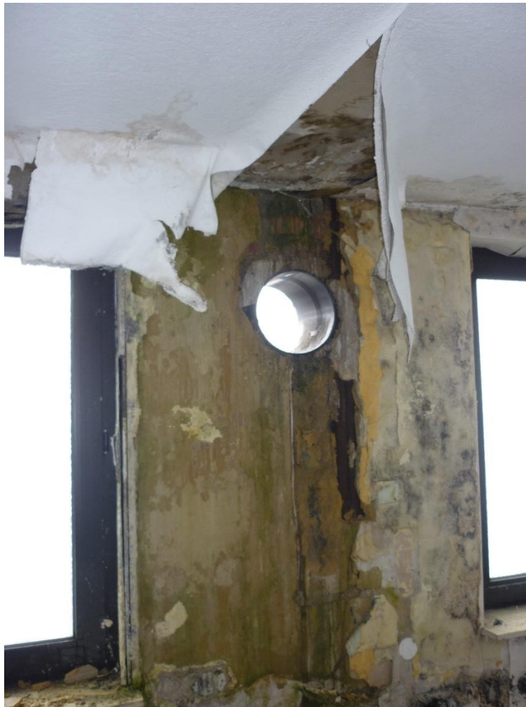
Abbildung 6: Offenes Belüftungsrohr im Hotelanbau, der als Zugang zum Gebäudeinneren dienen kann.
