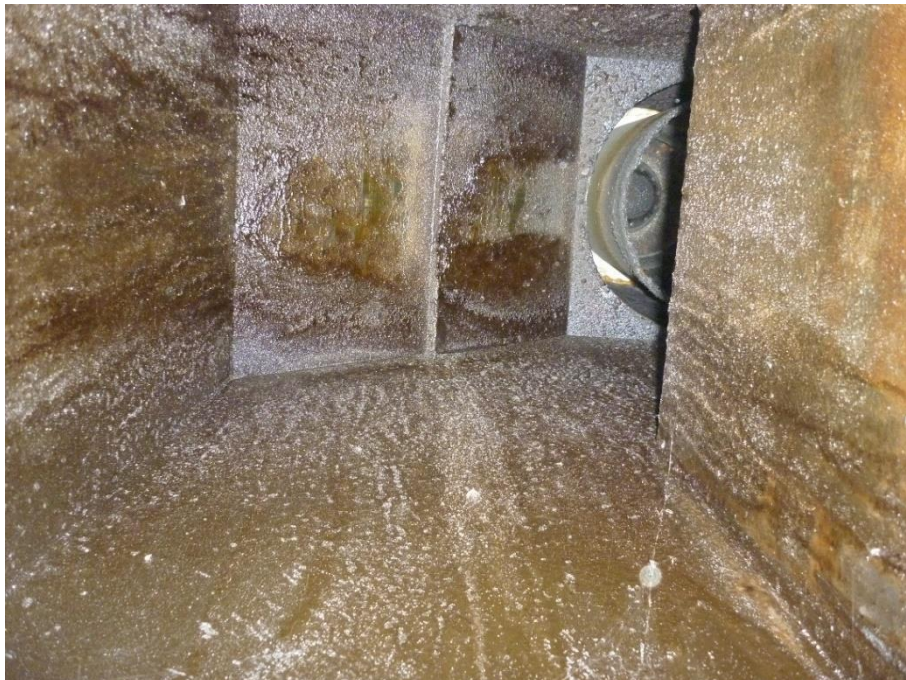
Abbildung 9: Blick in einen Belüftungsschacht von Innen.
