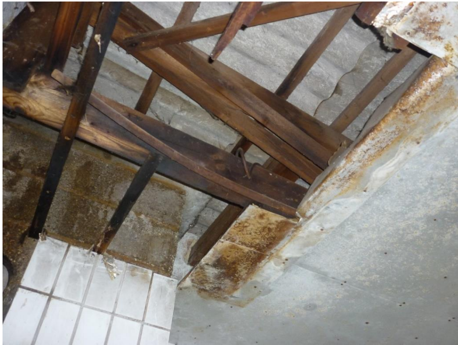
Abbildung 10: Blick auf die Dachkonstruktion eines Nebengebäudes.
