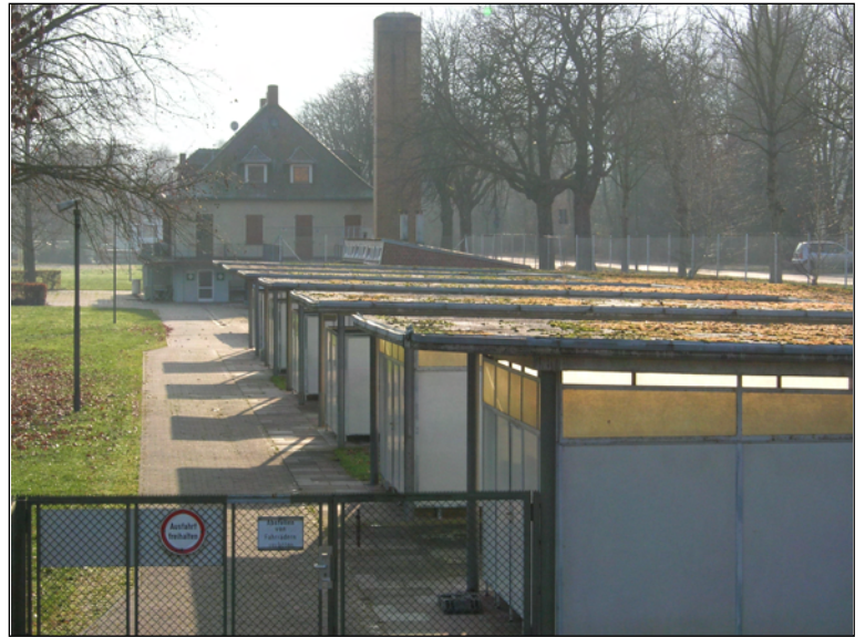
Umkleidekabinen, im Hintergrund Heizzentrale und Empfangsgebäude
