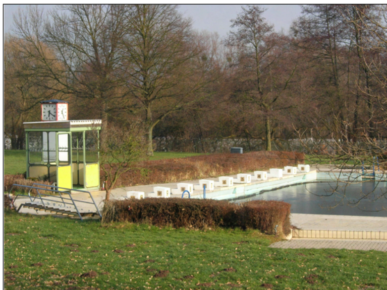
Schwimmerbecken, Kabine Badeaufsicht
