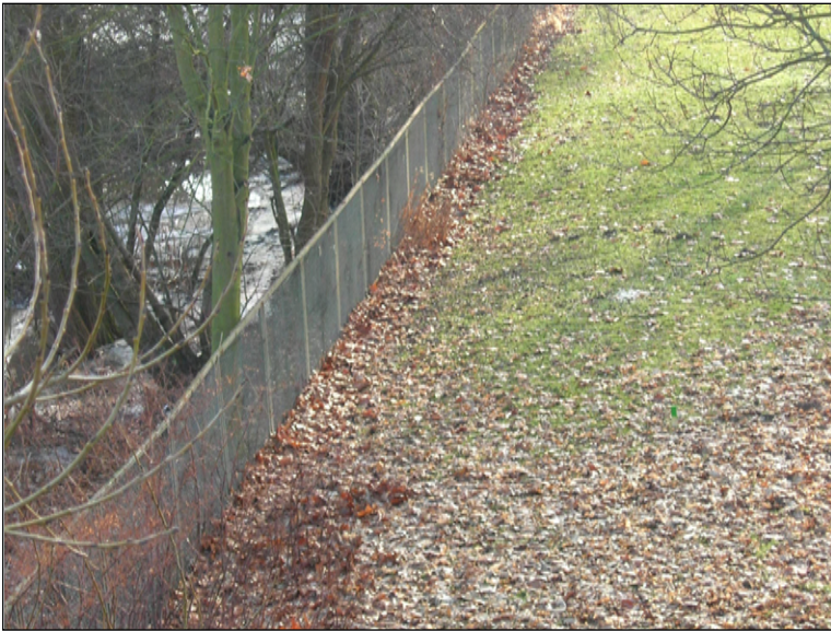
Abzäunung Schwimmbadgelände, Fuldaufer
