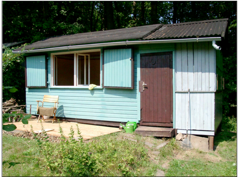
Laube, Dachdeckung rechts mit Bitumenwellplatten
