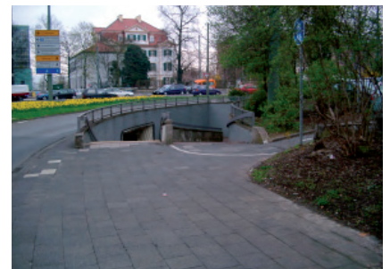
Fußgängerrampe an der ‚Trompete‘
