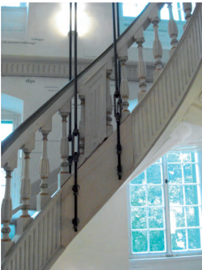
Konstruktion zur Stabilisierung der historischen Treppe
