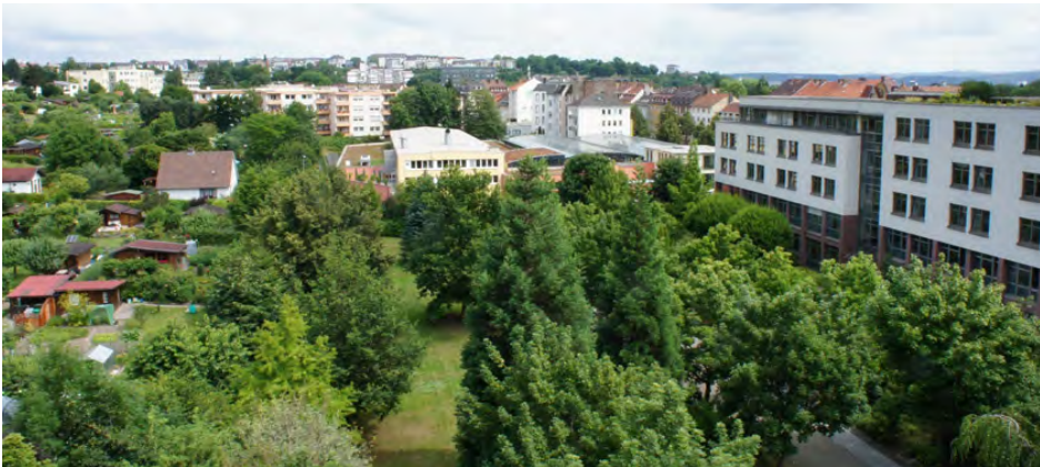
Blick über die Stellplatzanlage (parallel zur Frankfurter Straße), dahinter der Verbrauchermarkt (EDEKA)
