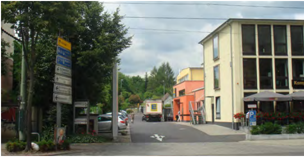
Zufahrt Stellplatzanlage EDEKA mit SVLFG-Zufahrt
