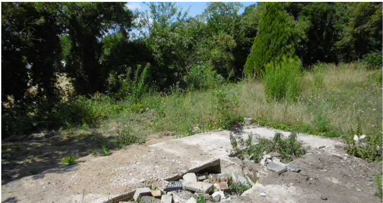
Fundamente einer ehemaligen Gartenlaube
