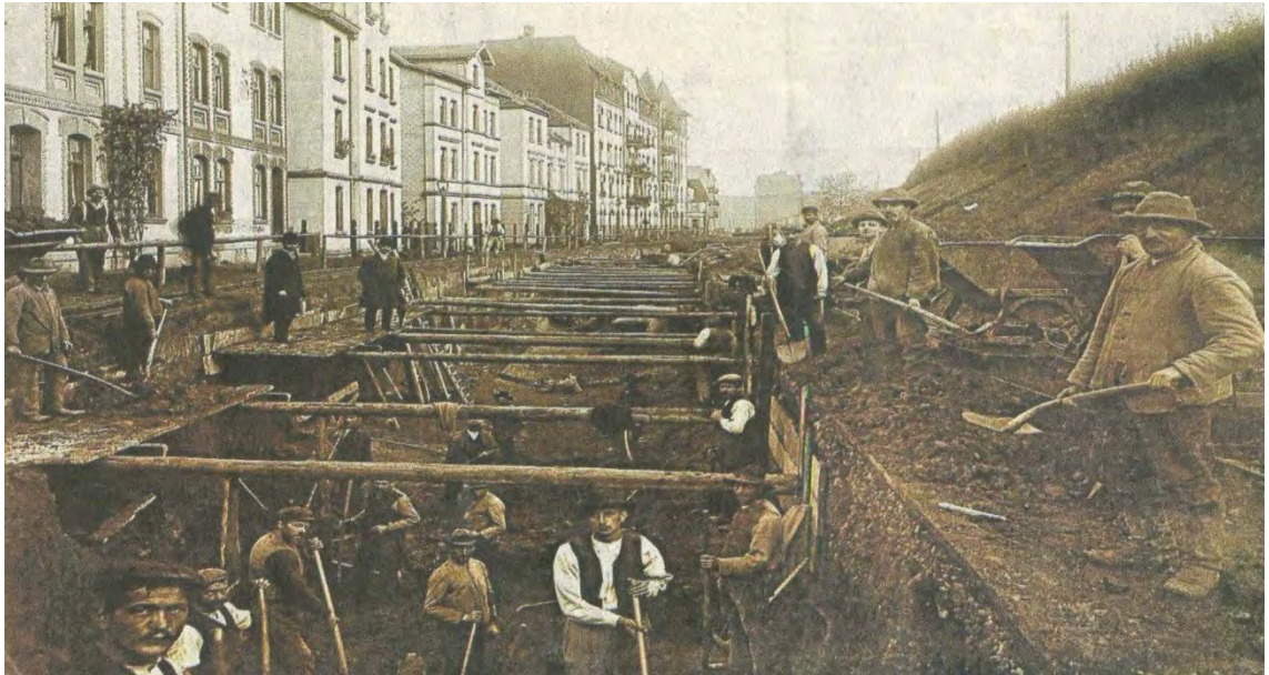
Bau der Mombach-Verrohrung (1911), rechts die noch fast vegetationsfreie Böschung des Unterstadtbahnhofs; Quelle: HNA, 07.08.2013
