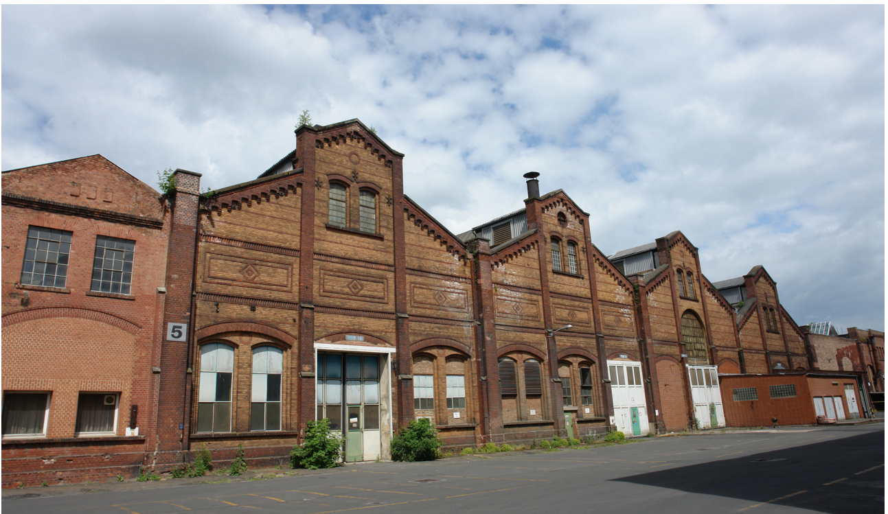
Die Kesselschmiede im ehemaligen Henschelwerk in Rothenditmold
