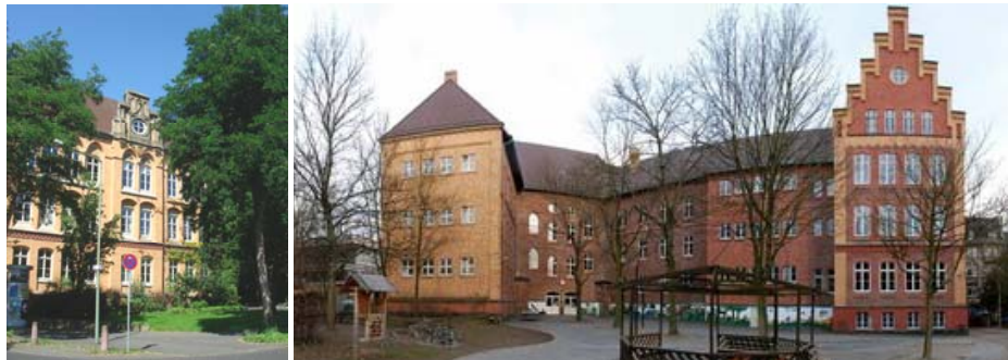
Straßenansicht von Osten
