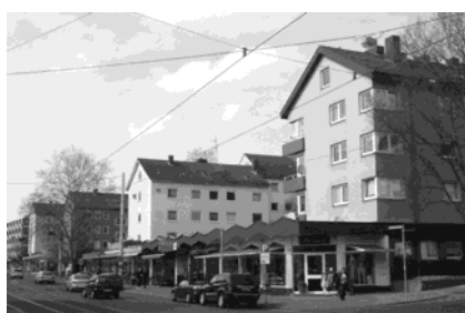
die kammartige Baustruktur gegenüber (heute)
