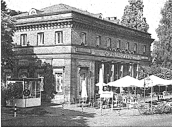
Alte Wache, links Kiosk
