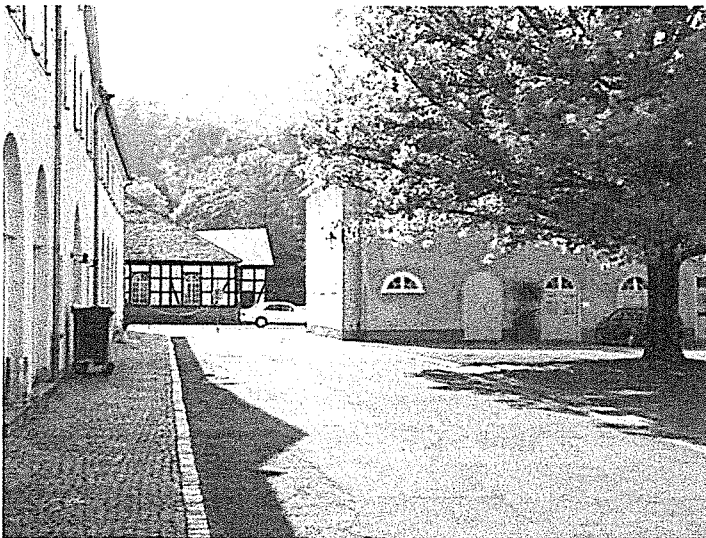
Innenhof mit Blick auf Reithalle, Remise links
