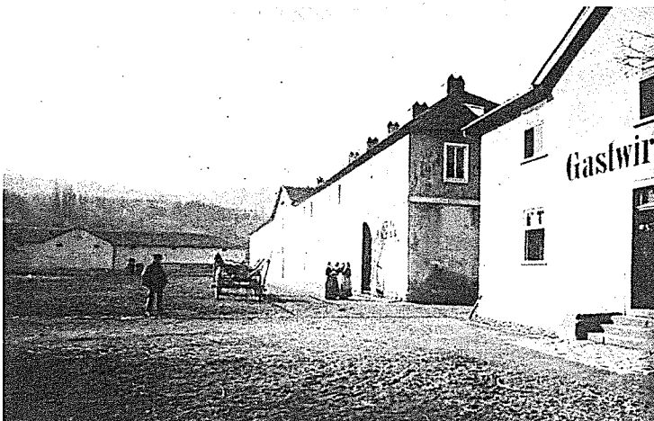
Südliche Remise, rechts Ausweichgaststätte, ca. 1890
