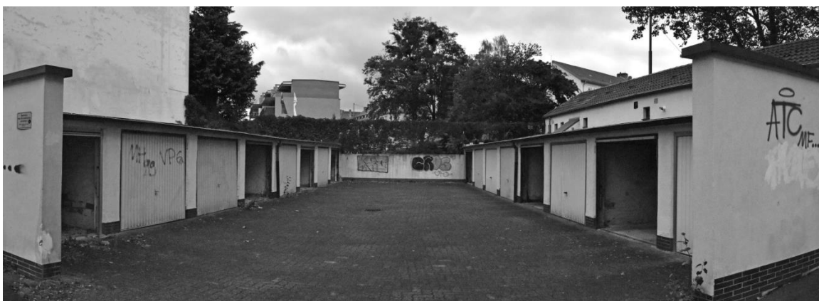
Abb. 1: Eingefriedeter Garagenkomplex, Blickrichtung Nordwesten
