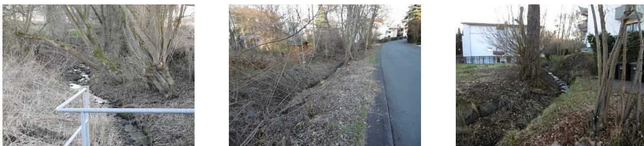
Abb. 10 – 12: Von links nach rechts: - Kellersbach westlich der Wegelänge außerhalb des Plangebiets - Abschnitt parallel zur nördlichen Stichstraße ‚Wegelänge‘ - an der Korbacher Straße südlich des Beginns der Verrohrung
