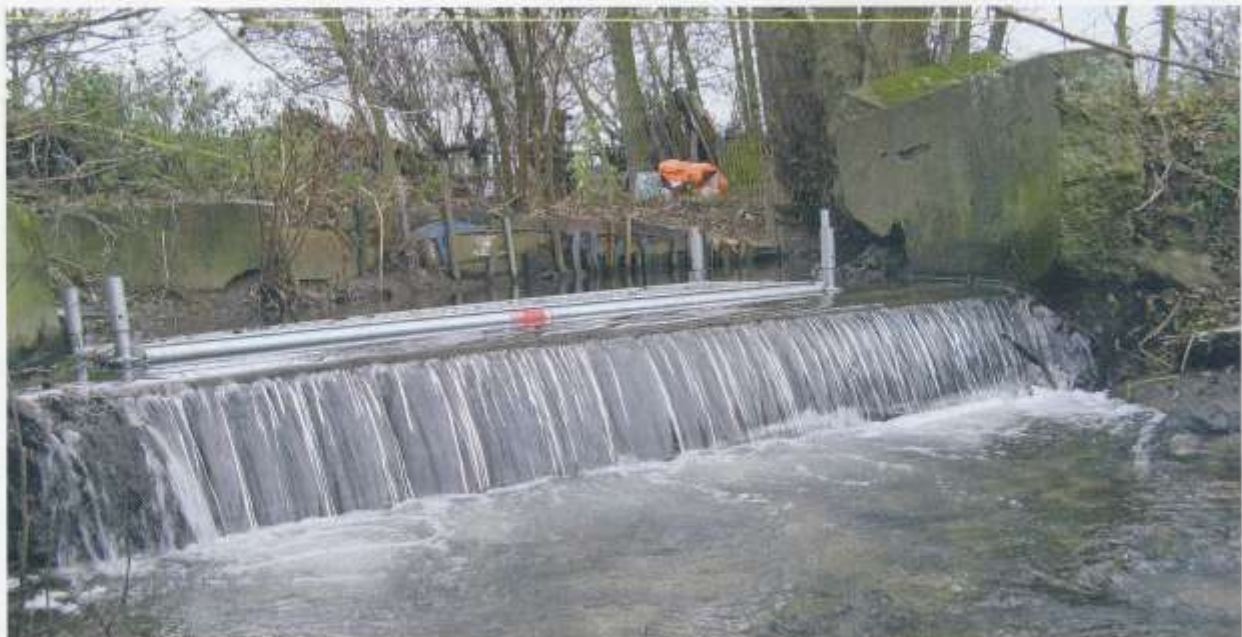
Abb. 10: Sohlabsturz am Wickerbach (Hochheim/Main)
