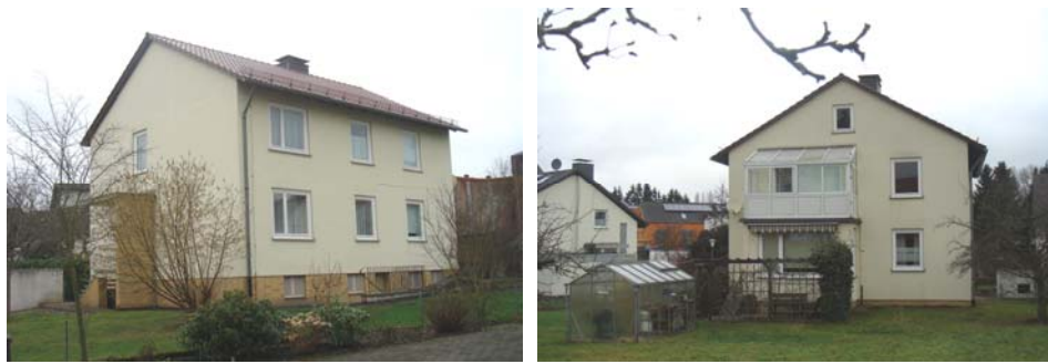
Fotos Bestandsgebäude Wasserweg 5
