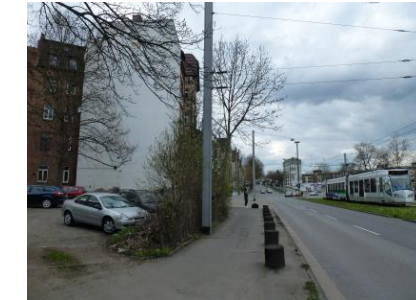
Straße Am Auestadion, links Privatparkplatz Frankfurter Straße 153
