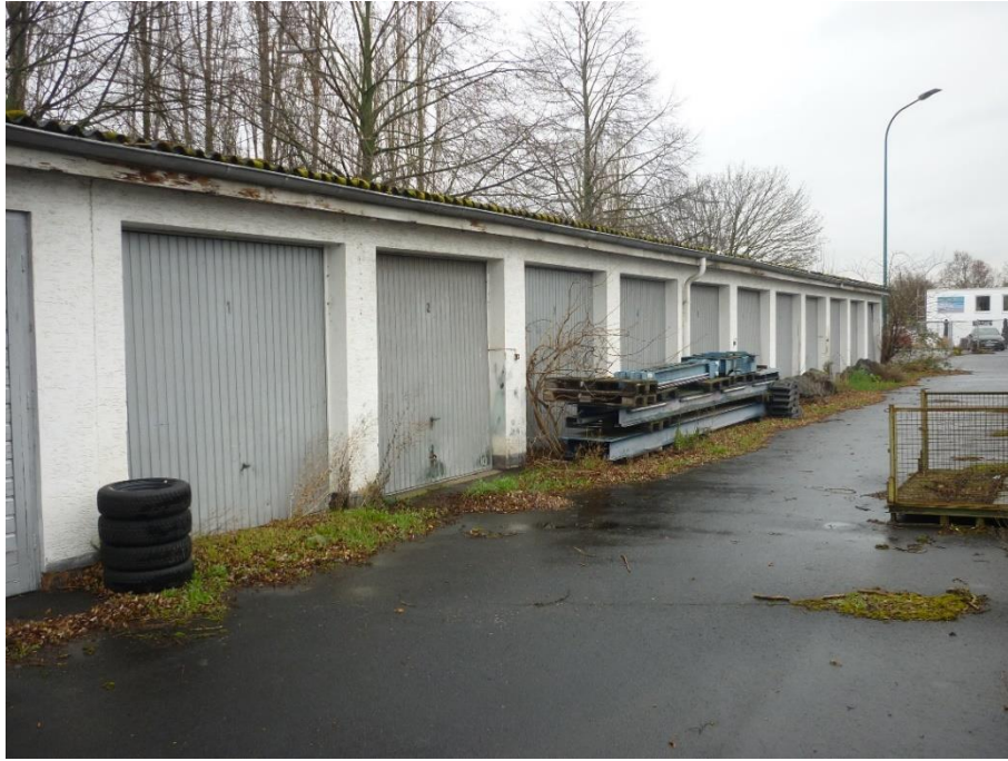
Abbildung 14: Blick entlang der Garagen. Einige der Garagen sind zugestellt, um sie vor Fremdnutzung zu schützen.
