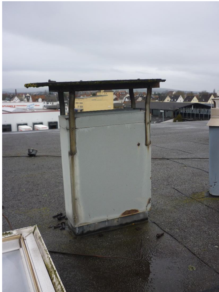
Abbildung 8: Lüftungsschacht auf dem Flachdach des Hotels.
