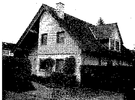
Wohnhaus für Betriebsangehörige Georg-Fladung-Str. 2
