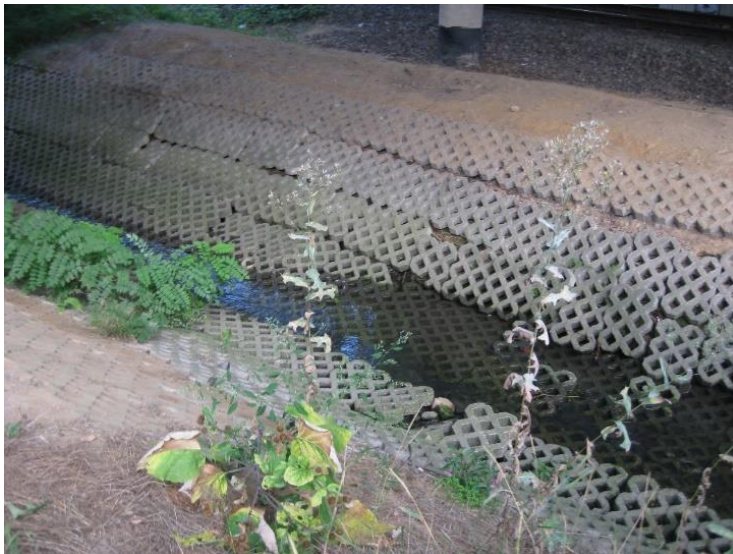
Abb. 29: Gewässerunterführung Gobietstraße (Quelle: Umwelt- und Gartenamt; Umweltplanung)
