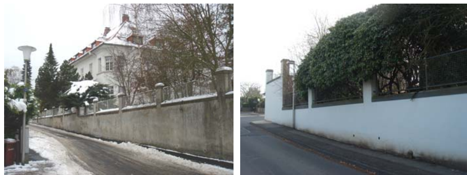
Mauer in der Kuhbergstraße und
