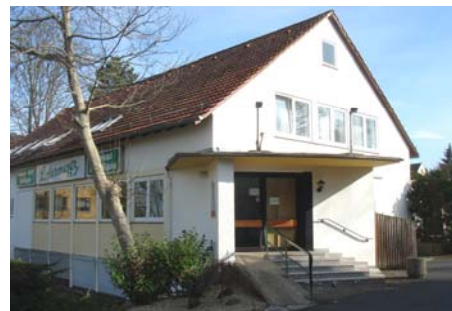
Traufseite Nord bzw. Eingangsseite West
