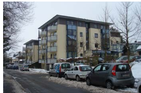
und Haus am Stiftsheim Firnsbachstraße 6
