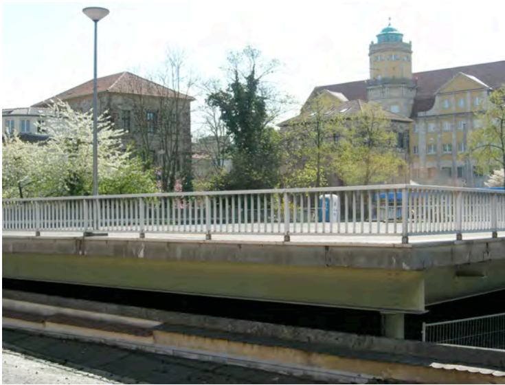
Ehemaliges Parkdeck Wilhelmshöher Allee 4, im Hintergrund Torwache und Landesmuseum
