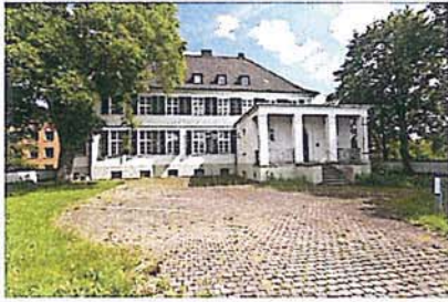
Blick von der Frankfurter Straße aus auf die denkmalgeschützte Villa
