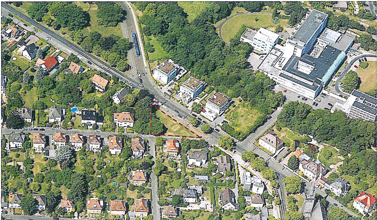
Luftbild, Ansicht von Osten, Geltungsbereich gekennzeichnet (Stadt Kassel, Amt für Vermessung und Geoinformation)
