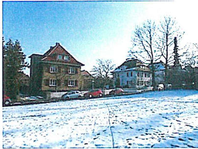
Blick von Westen über das Baugrundstück
