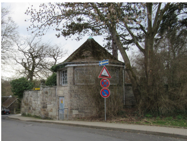
Pavillion an Nordostecke
