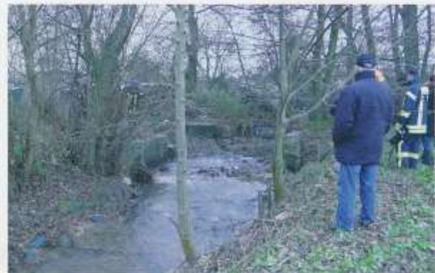
Abb. 13: Wickerbach nach der Wehrsprengung
