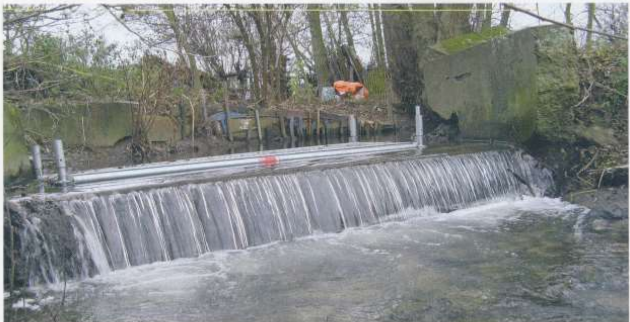
Abb. 10: Sohlabsturz am Wickerbach (Hochheim/Main)
