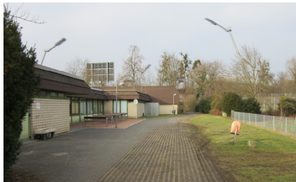
Bereich vor zukünftigem Halleneingang
