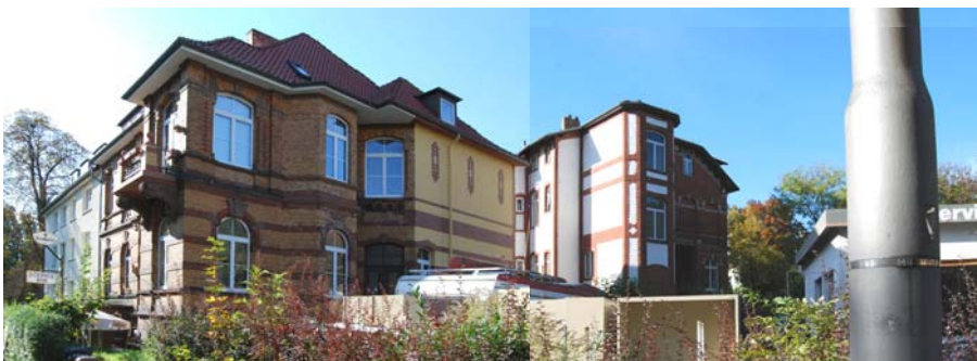
Nachbarbebauung: Germaniastraße 11 und 13 (links) und Goethestraße 49 (rechts)
