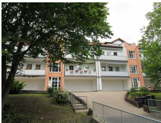
Mehrfamilienhaus ‚Am Stockweg‘
