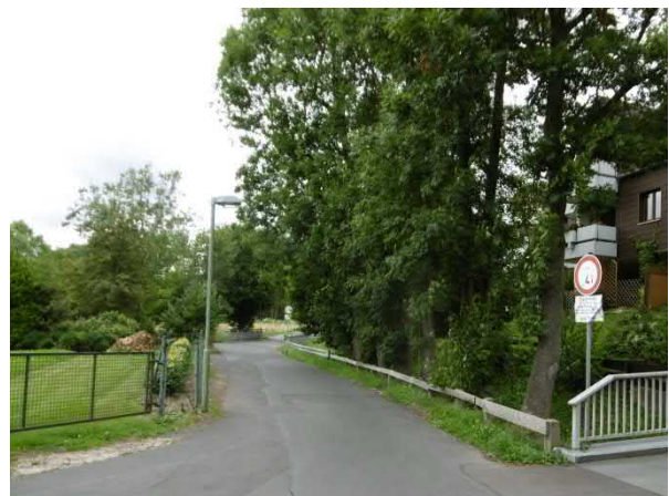
Geilebachgrünzug (‚Am Stockweg‘) westlich des Plangebiets
